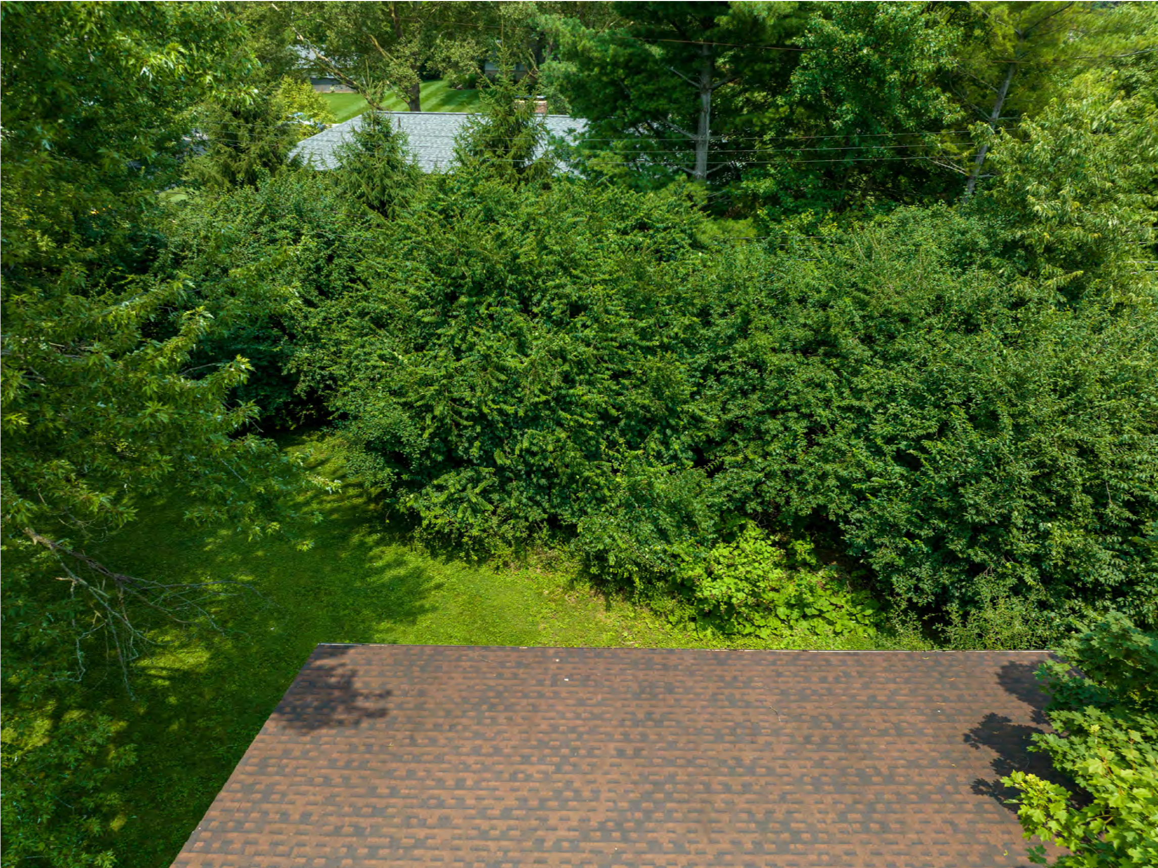
DRONE VIEW @ 35'-0" SCALE: N.T.S. LOOKING NORTH
