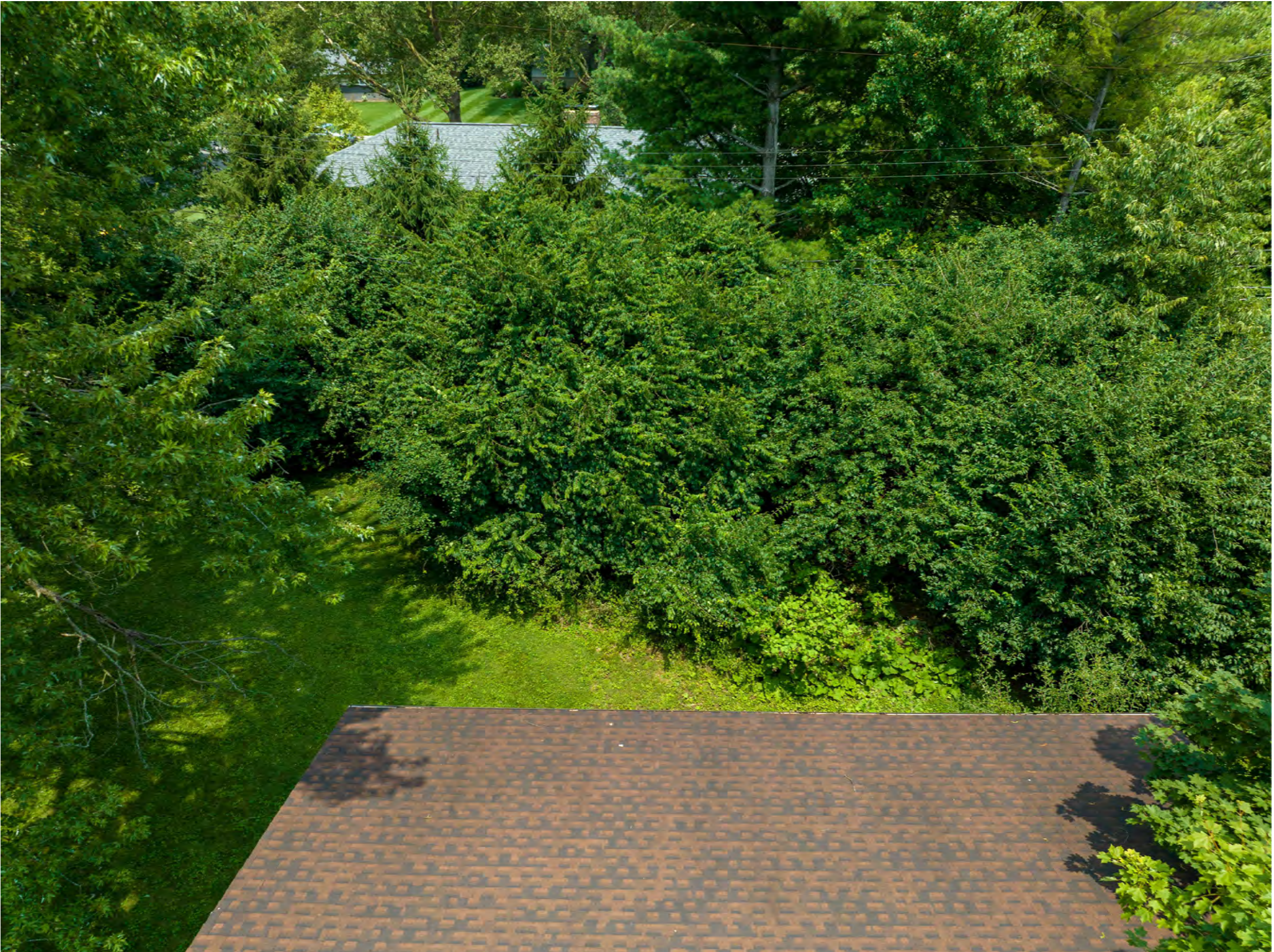
DRONE VIEW @ 35'-0" SCALE: N.T.S. LOOKING NORTH
